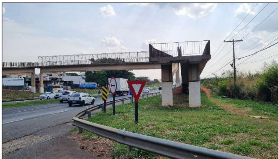
Foto 11. Rodovia Luiz de Queiroz – km 125.
